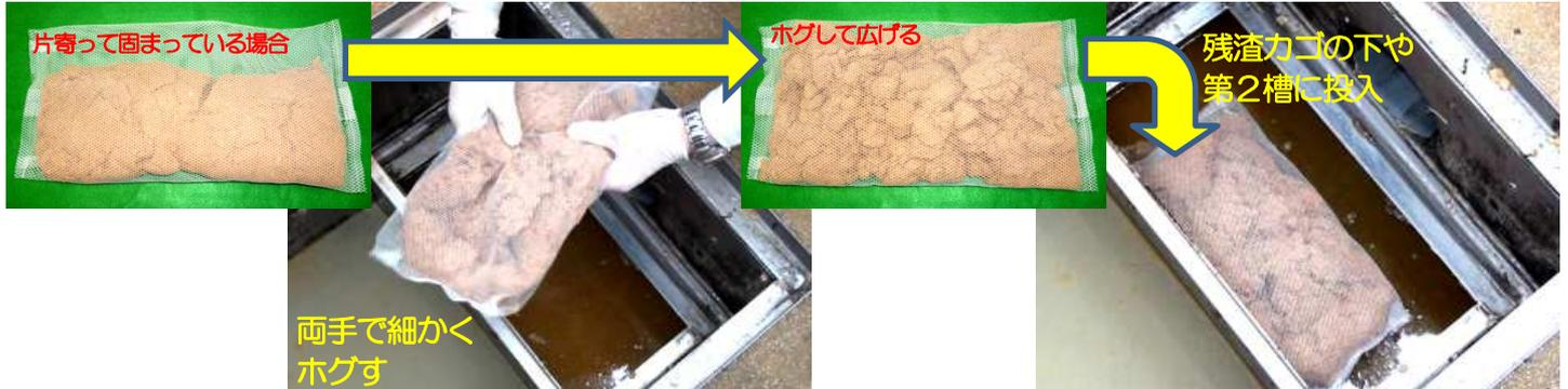
吸着素材が固まっている場合、ホグしてネット内に広げ、残渣カゴの下や第2槽などに投入する。この1個で約1kgの油を吸着します。(※ホグすときにネットが破れやすいのでご注意ください)
